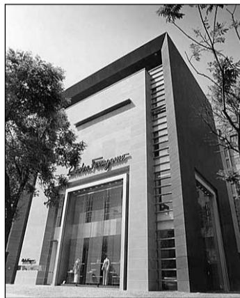
Sopra, lo shop Ferragamo di Seul
