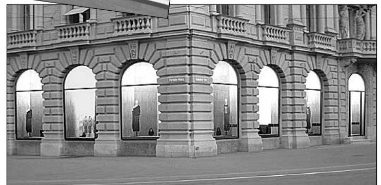
A lato, la boutique Giorgio Armani di Zurigo. Sopra, quella di Atene
